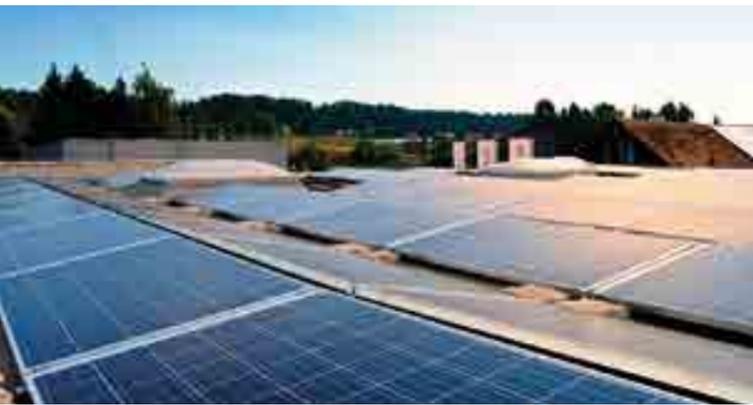
Die neue PV-Anlage am Dach hat eine Nennleistung von 140 kWp.
