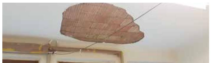
Bei Malerarbeiten löste sich Putz von der Decke, eine Sanierung wurde rasch durchgeführt.
